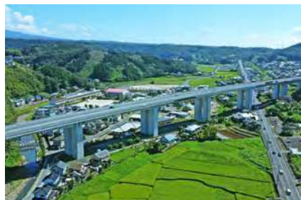
ゲルバーヒンジ部の連続化 鈴田橋
