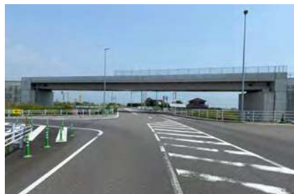
軟弱地盤上の橋梁設計 芦刈南IC橋
