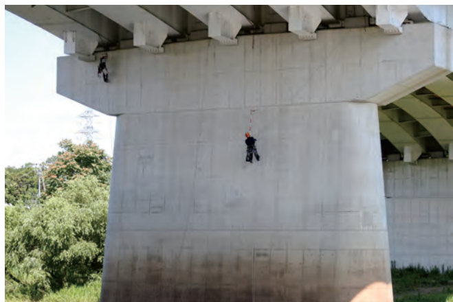
ロープアクセスによる点検（愛知県豊田市）
