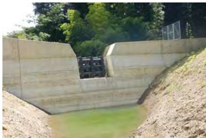
不透過型堰堤の機能改良 春哉川砂防堰堤
