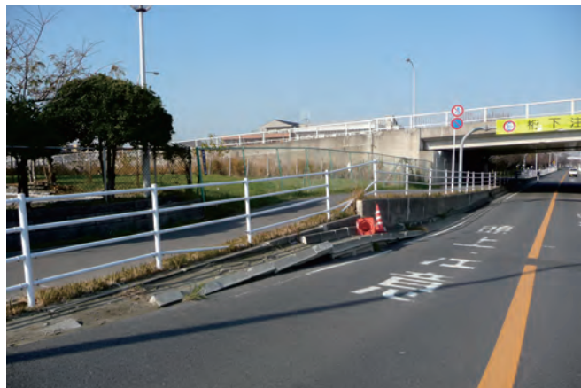
大規模地震後の道路点検（千葉県浦安市）
