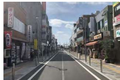
商店街通りの再整備と無電柱化 市道17号線
