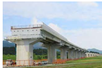
高速道路の施工管理 北勢第一高架橋
