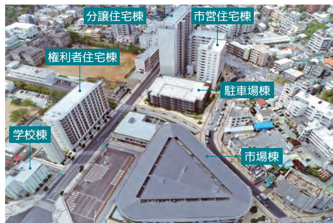
農連市場地区防災街区整備事業（沖縄県那覇市）
