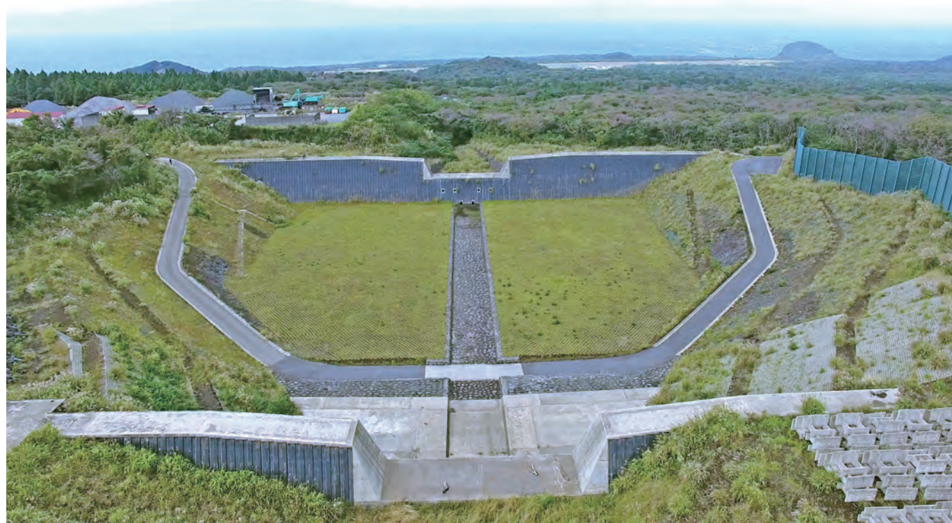
伊豆大島総合溶岩流対策事業における北の山川砂防施設の基本計画から予備設計、詳細設計、補足設計を一連で実施（東京都）
