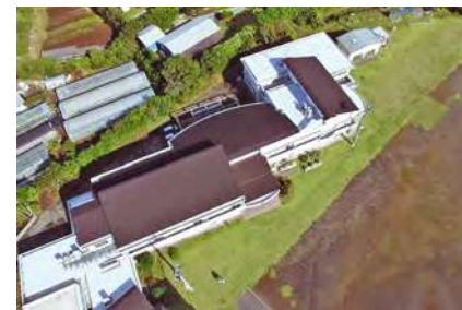
建物調査・長寿命化計画 八丈町立小中学校
