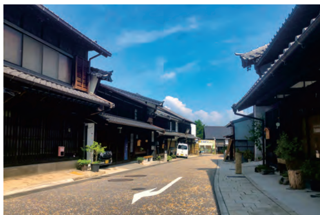
中津川宿の町並み整備（岐阜県中津川市）
