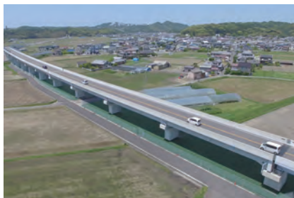
県道バイパスの高架橋の設計 南白浜高架橋
