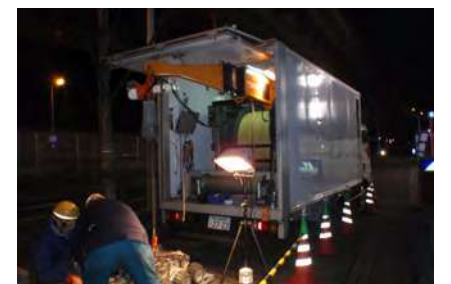
下水道管渠調査 南大阪湾岸流域
