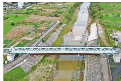
水管橋の設計 観音橋水管橋
