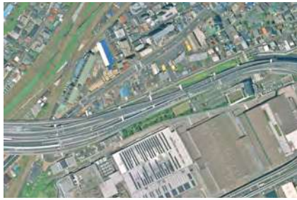
日照阻害（連続高架橋整備） 首都高速神奈川7号横浜北線
