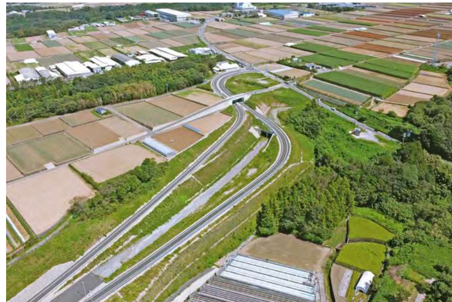
インターチェンジの設計 一般国道251号
