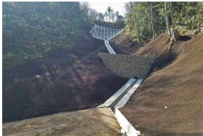
復旧工事完了
