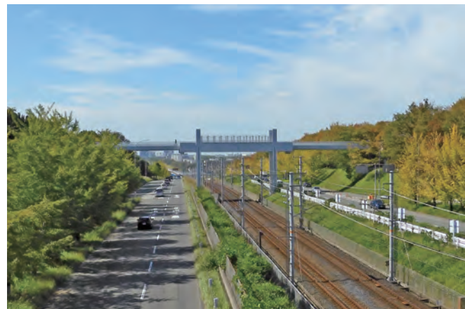
橋梁の耐震補強（大阪府堺市）
