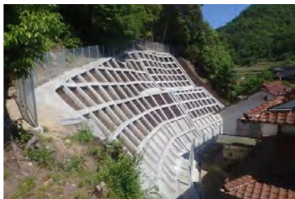
平成30年7月豪雨の復旧設計 復旧法面9地区
